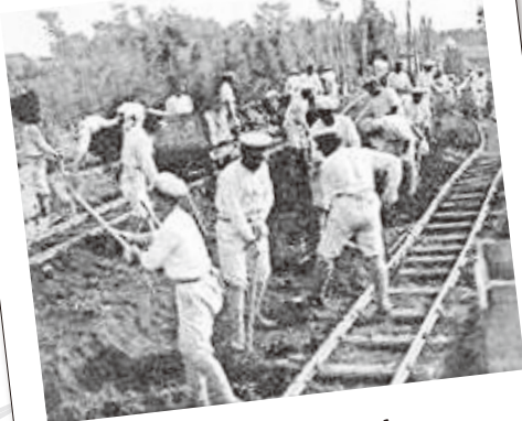
路盤構築のようす
